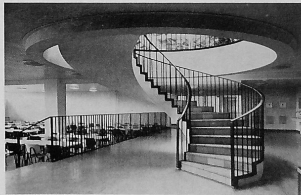
Nedgang til frokoststuen
